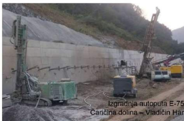
Građevna jama Sarajevo Tower
